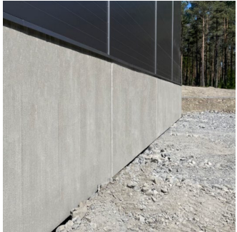
SOCKEL: Betong grå
